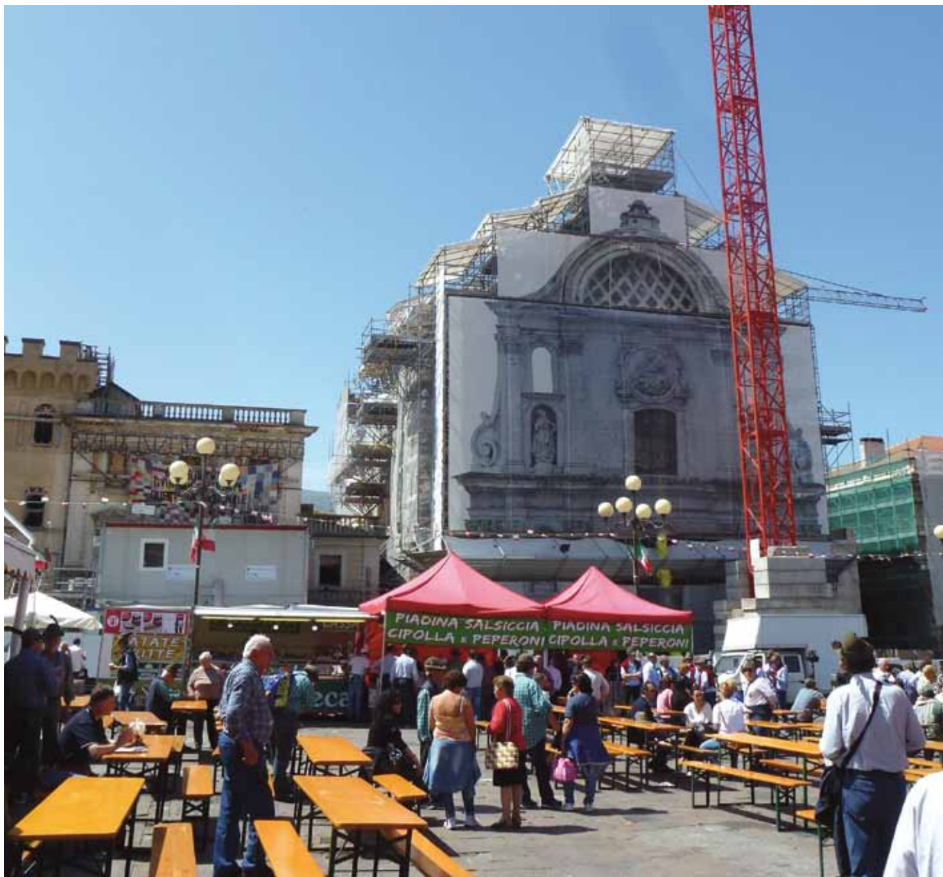
L'Aquila Piazza Duomo. Lavori di restauro durante l'Adunata Nazionale degli Alpini nell'anno 2015. (Foto: Mario Salvitti)
