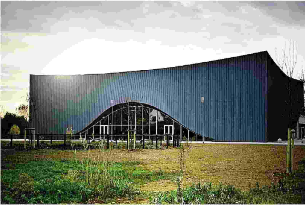
La nuova palestra di San Tomaso, dal design contemporaneo, è affacciata sul Parco Ovest FOTO BEDOLIS
